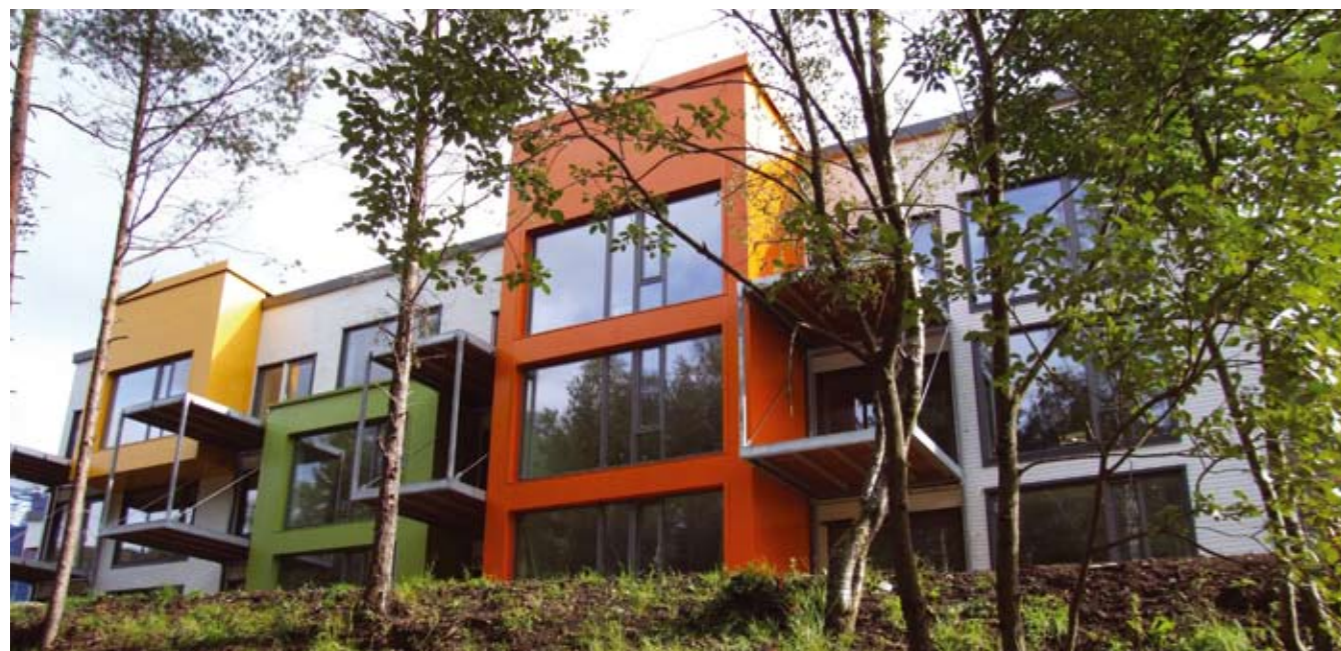
Norwegens erste Passivhausanlage in Løvåshagen bei Bergen Norges første passivhusanlegg på Løvåshagen i Bergen
